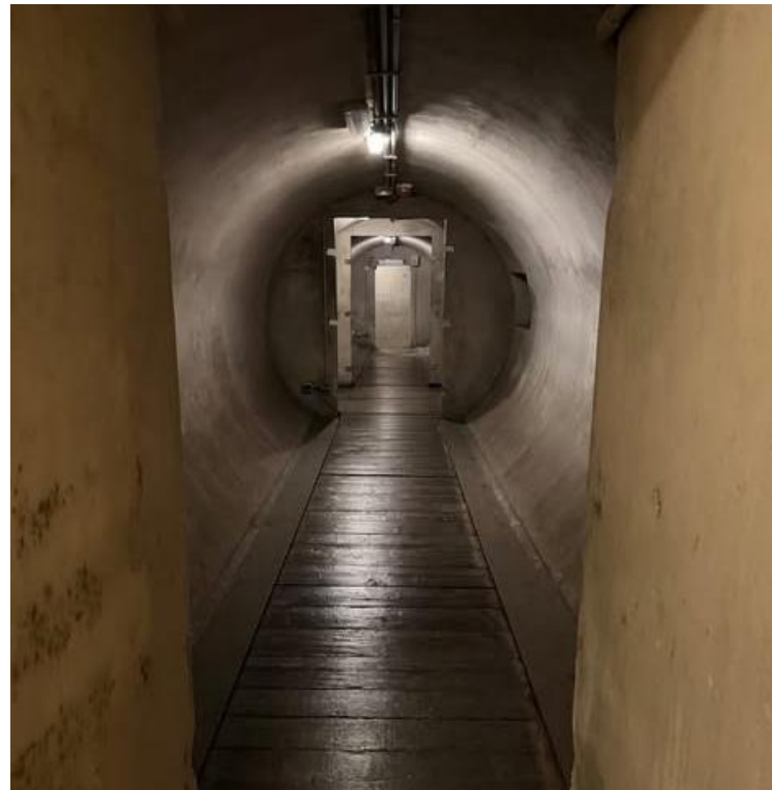
No subsolo: bunker e abrigo antiaéreo.
